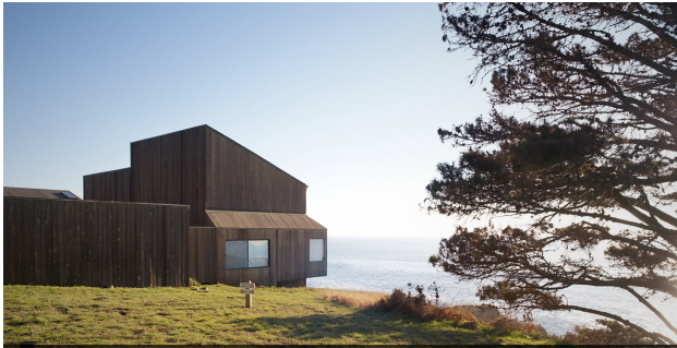
-Sea Ranch Condominium One- カリフォルニアの岩壁から太平洋を臨む、C. ムーアによる「伝説の建築作品」。 この環境下で60年を経て、レッドウッドの外壁は朽ちることを知らない
